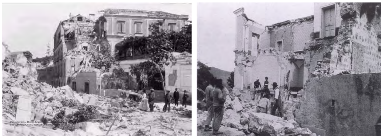
Figura 3. Terremoto 1883. Casamicciola – Hotel Manzi (sinistra) (Foto Sommer); Pensione Verde dove alloggiava la famiglia di Benedetto Croce (destra) (Foto Mauri, coll. priv. G. Fiorentino). [Cubellis e Luongo, 1998].
