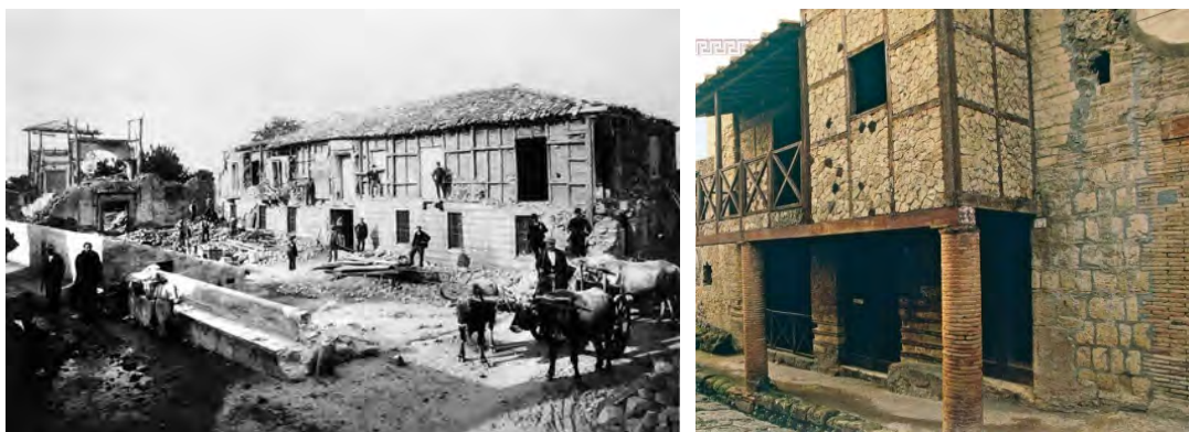
Figura 4. Casa baraccata di epoca borbonica rimasta in piedi dopo il terremoto del 1908. A fianco una casa a graticcio del I secolo d.C. rinvenuta a Ercolano da La Vega.
