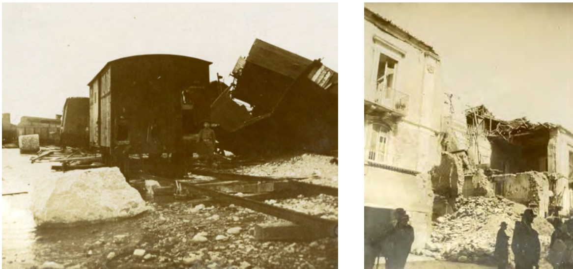
Figura 9. Messina distrutta dal terremoto del 1908. Foto di G. Mercalli. (Archivio storico Reale Osservatorio Vesuviano).
