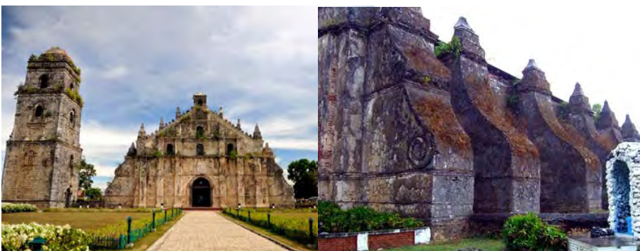
Figura. 2. Esempio di architettura antisismica nota come “earthquake baroque”. Chiesa di Sant’Agostino (nota come Chiesa di Paoay) a Ilocos Norte nelle Filippine, costruita nel 1694, su commissione dei frati Agostiniani guidati da padre Antonio Estavillo. La chiesa fu completata nel 1710.
