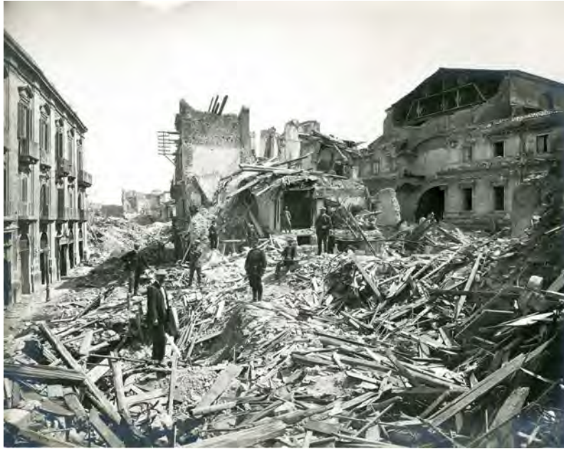
Figura 3. Messina, danni causati dal terremoto del 28 dicembre 1908.
