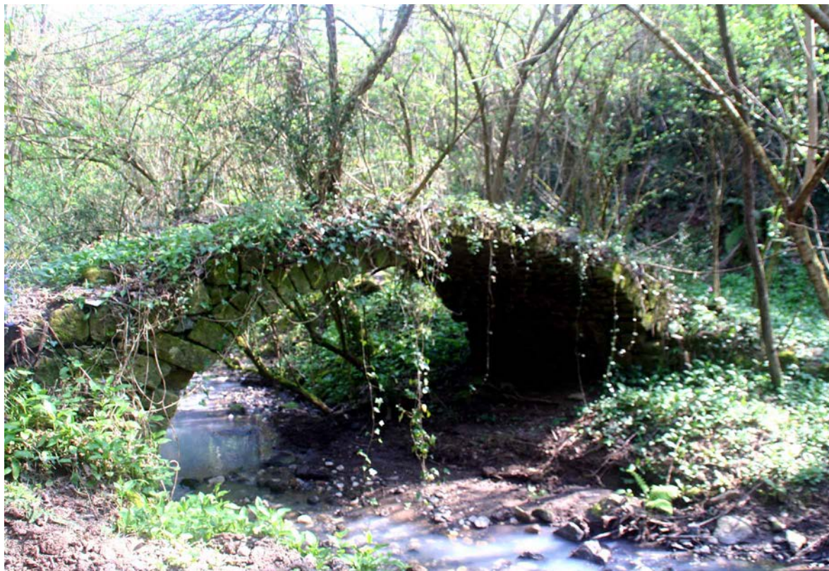
Figura 6.2 Ponte sul Fosso Rianale.
